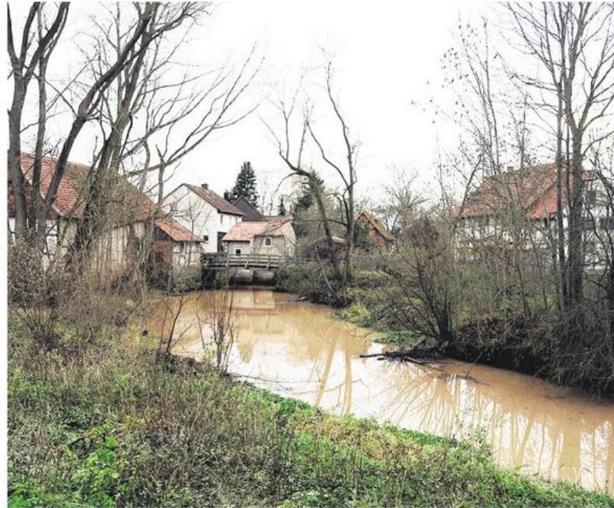
Hochwasser an der Leineinsel: auch die Insel soll von Schutzmaßnahmen profitieren.
